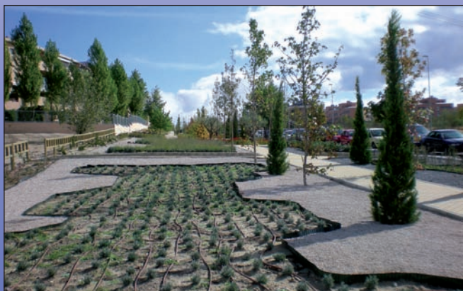
La Concejalía de Vías Públicas es una de las áreas municipales que receptiona trabajadores del programa de obras y servicios.
